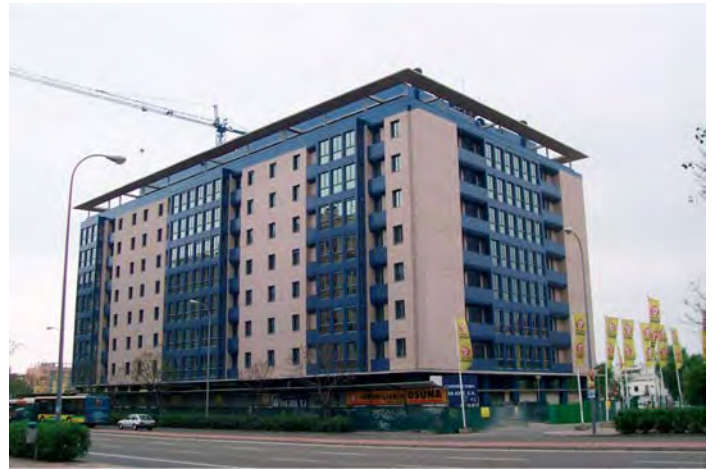
Edificio Maestranza, Sevilla
