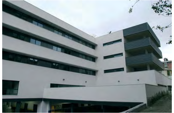
AMMA Geriatric Centre, Puente de Vallecas (Madrid)
