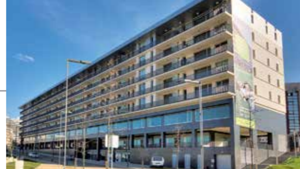
Bâtiment Novo Rumo, Maia (Portugal)
