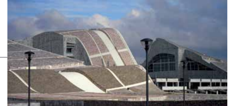
Bâtiment Administratif de la Ville de la Culture, Saint-Jacques-de-Compostelle
