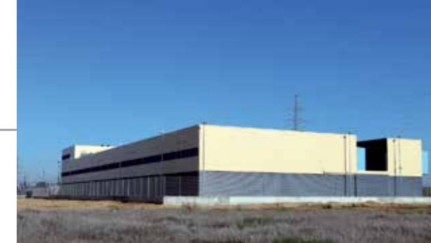
Bâtiment Aeronautic Suppliers Village dans le Parc Technologique Aérospatial d'Andalousie, Séville
