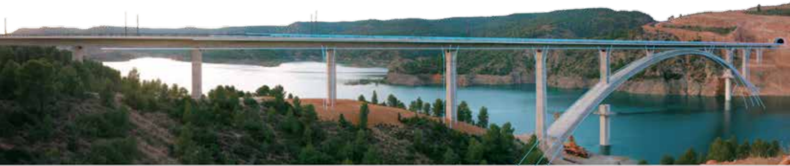
Tronçon du barrage de Contreras - Villargordo del Gabriel, AVE Madrid - Valence
