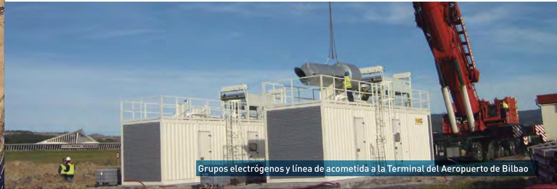
Grupos electrógenos y línea de acometida a la Terminal del Aeropuerto de Bilbao
