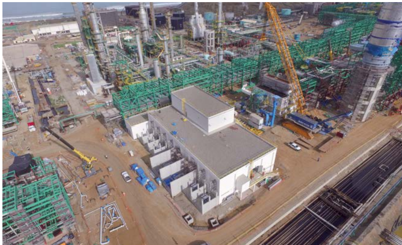
Bâtiments de Contrôle et Sous-Station Électriques. Raffinerie Talara - Piura (Pérou)
