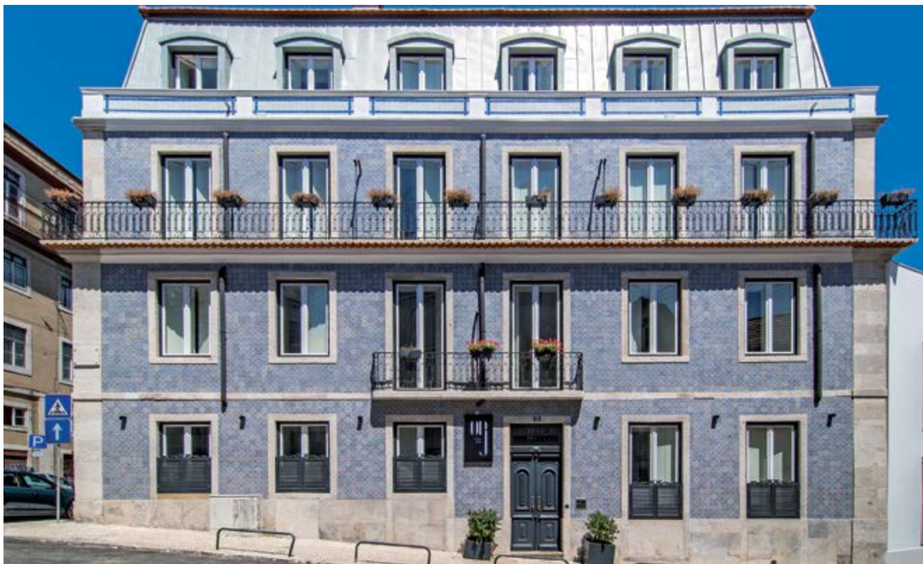
Réhabilitation Bâtiment de Logements Calçada do Desterro de Lisbonne (Portugal)
