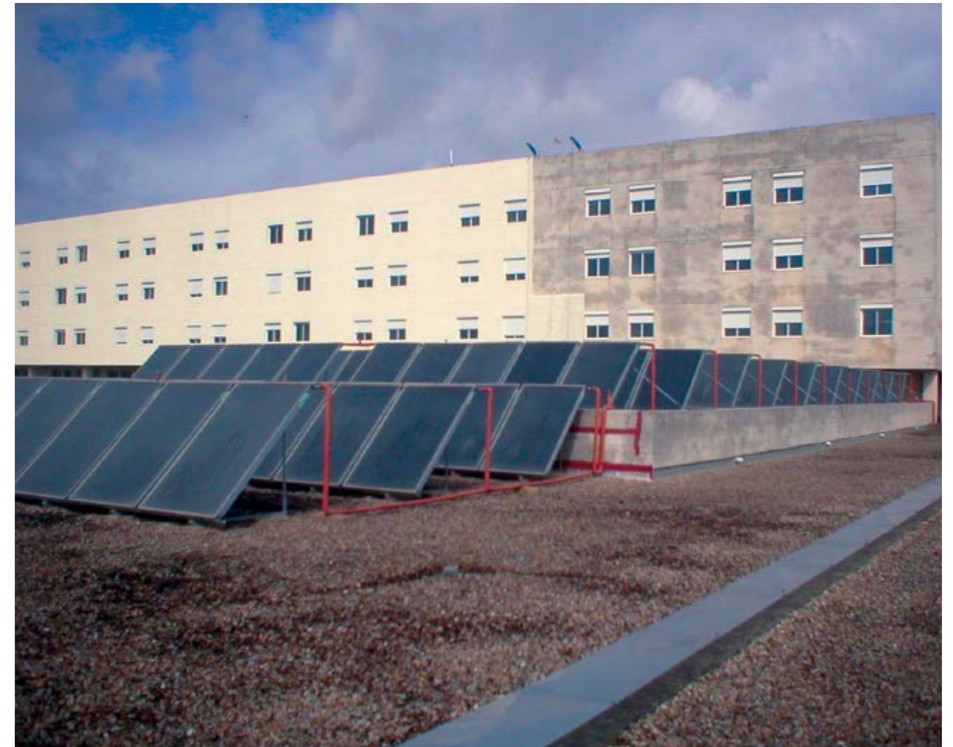
Hôpital de Puerto Real, Cadix (Espagne)
