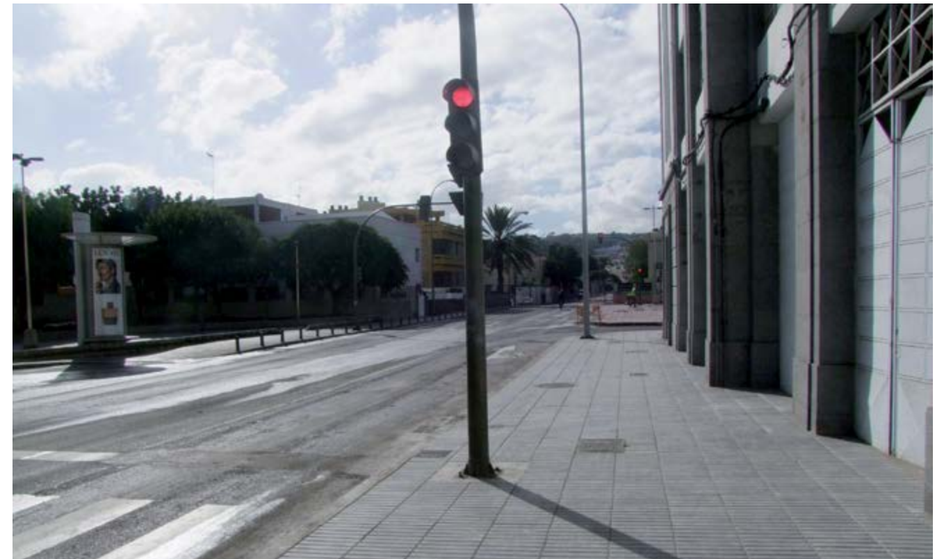
Tronçon 6 du Système de Transport Public Rapide à Las Palmas de Gran Canaria (Espagne)
