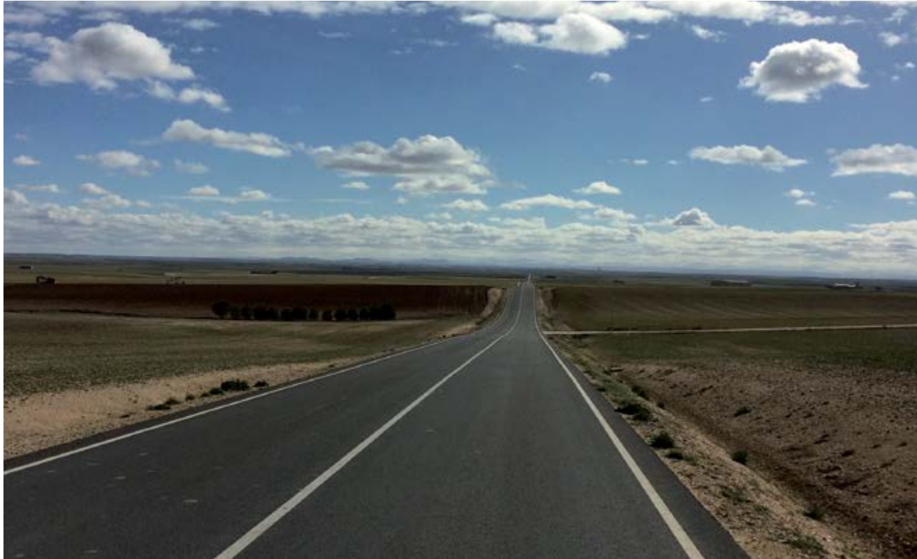
Renfort et rénovation des revêtements de la route SA-801 de Peñaranda de Bracamonte à CL-605, Salamanque (Espagne)
