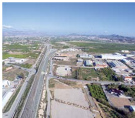
Tronçon Autoroute de Reguerón du Périphérique MU-30 de Murcie (Espagne)
