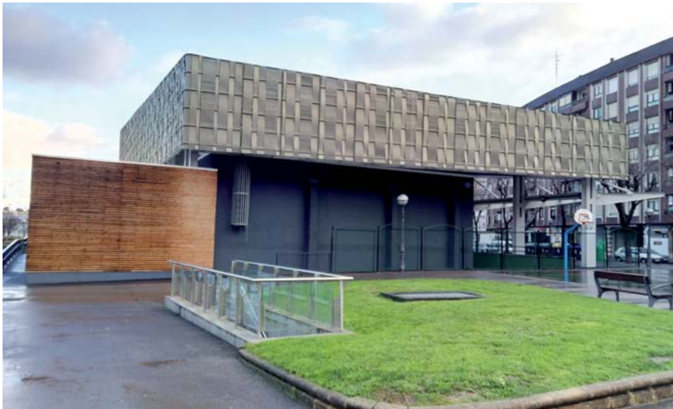
Réhabilitation et couverture du fronton de Plaza Azoka de Bilbao (Espagne)
