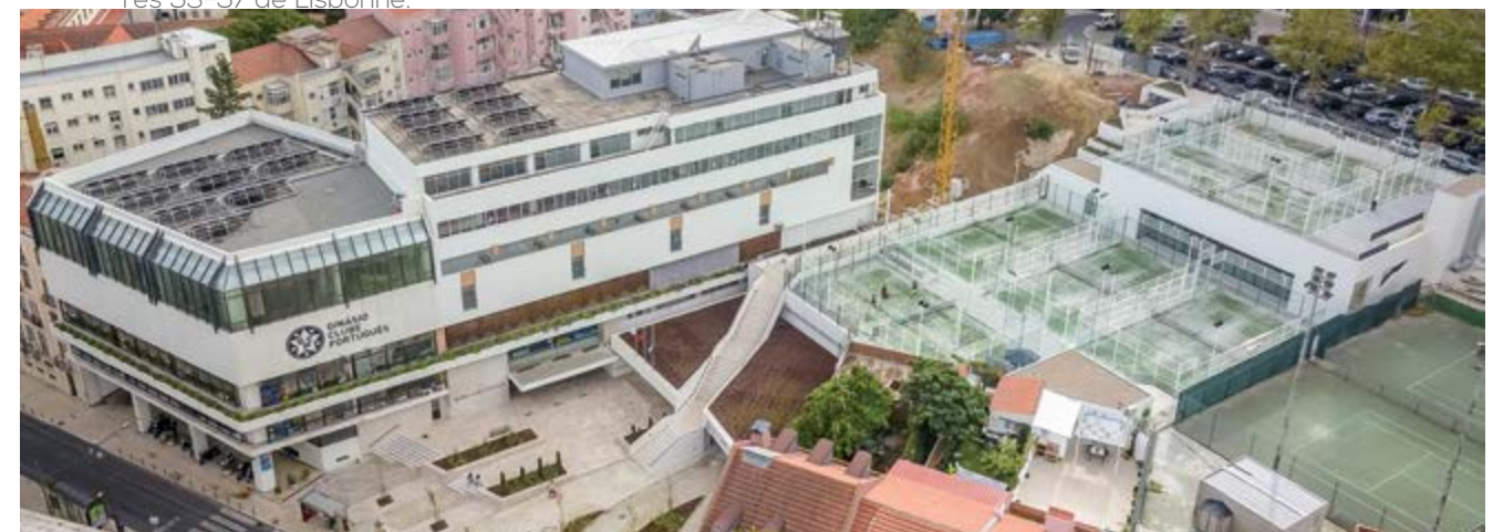
Travaux d'Extension et nouveaux stationnements souterrains du Gymnase Club Português de Lisbonne (Portugal)
