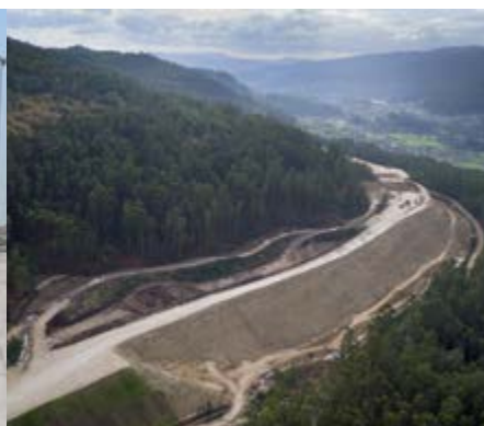
Tronçon Vilaboa - A Ermida de la future Autoroute A-57, Pontevedra (Espagne)
