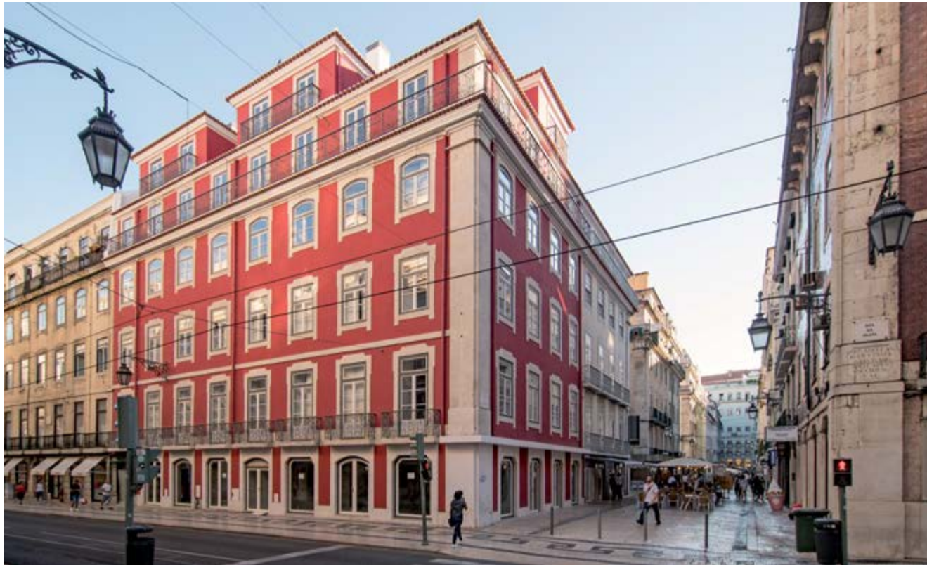
Réhabilitation ApartaHôtel de 4 étoiles de la rue da Prata, Lisbonne (Portugal)
