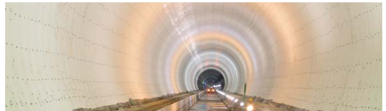
Tunnels de Pajares (travaux civils complémentaires Lot Sud). AVE Madrid - Asturies (Espagne)
