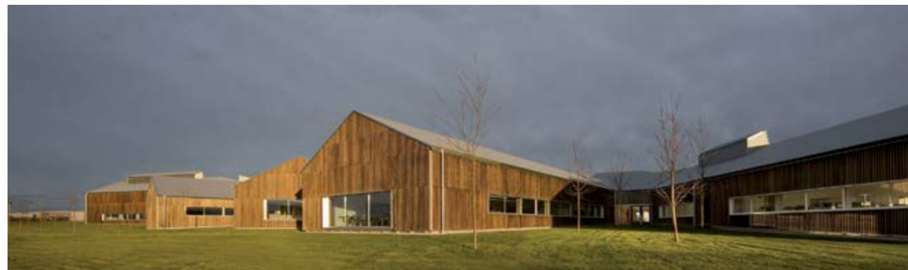
Siège de Norvento, Lugo (Espagne)
