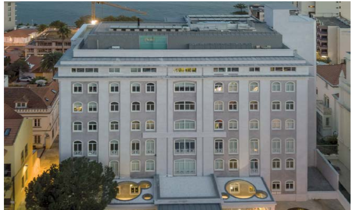
Résidence Grande Hôtel Monte Estoril (Portugal)
