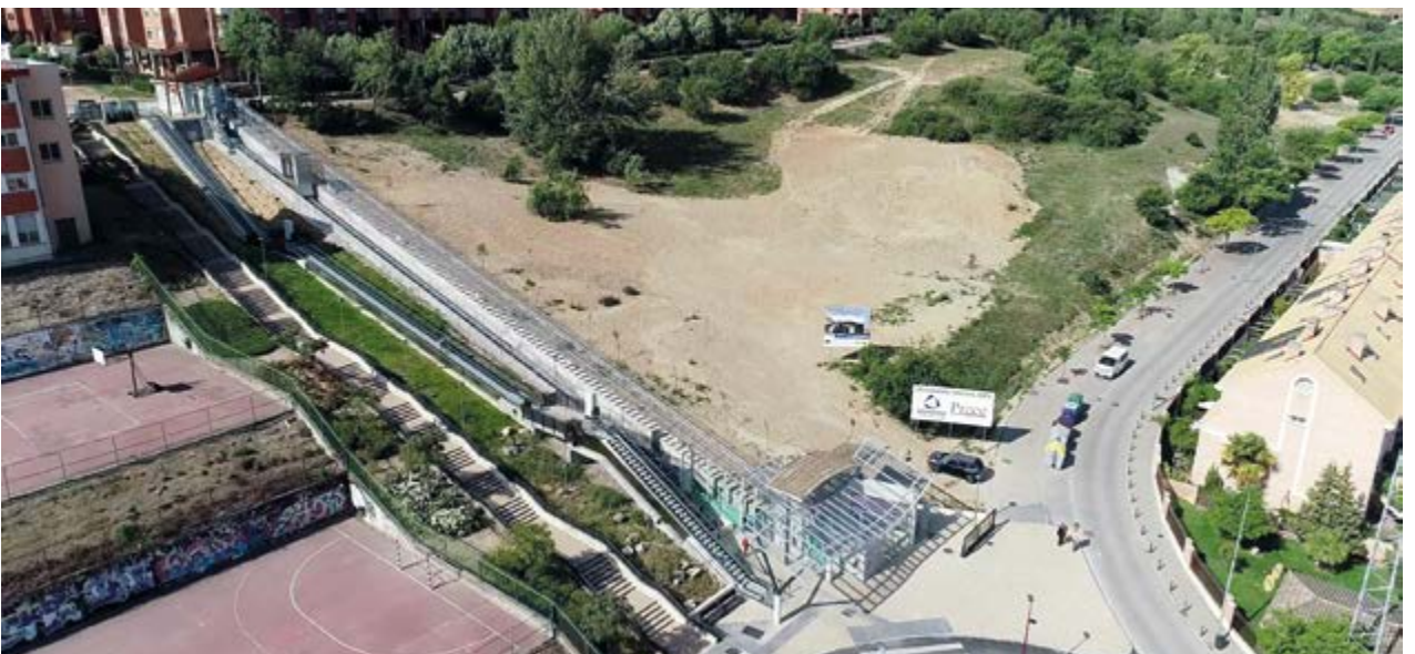
Movilidad vertical y elevadores mecánicos en la ladera Norte del barrio de Parquesol, Valladolid (España)
