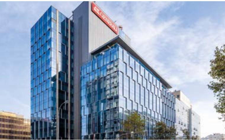
Edificio Generali en la calle Orense 4, AZCA – Madrid (España)
