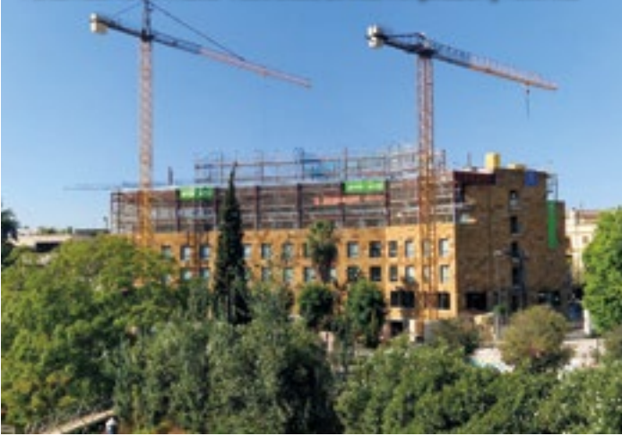
Hotel Ribera de Triana 4 estrellas, Sevilla. Ampliación y reforma
