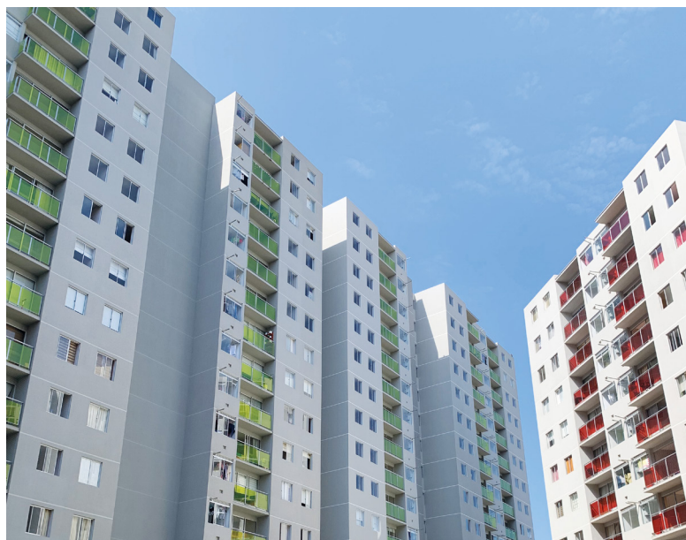
Nuevavista Condominium, Lima (Perú)
